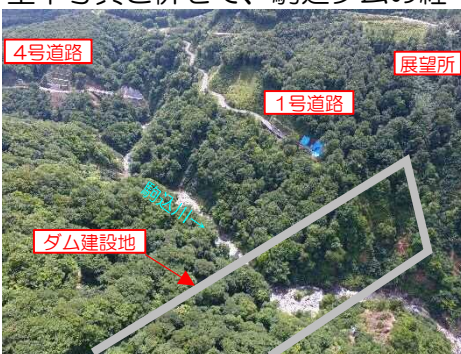
駒込ダム右岸側から撮影。1号道路はほぼダムサイト天端付近に到達！
