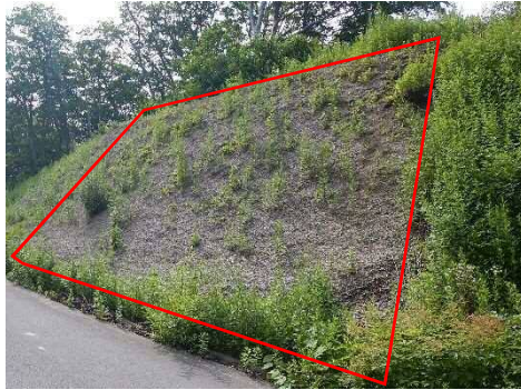
昨年度施工箇所。H29年8月撮影。周辺から種が飛んできて、少しずつ植生が図られています。
