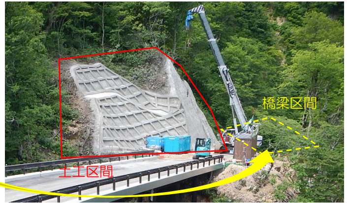
土工区間の法面対策完成（6月27日）
