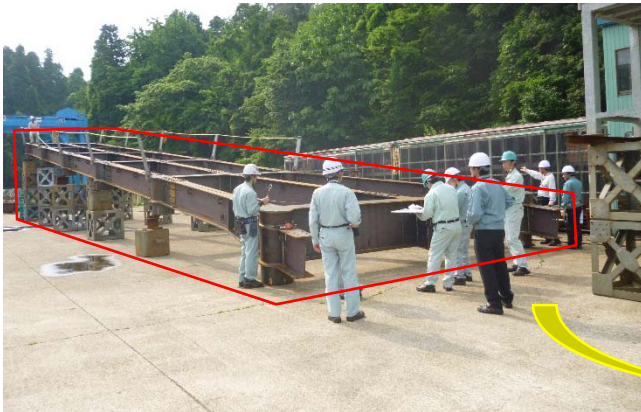
メタルロード上部工 工場製作仮組（6月1日）
