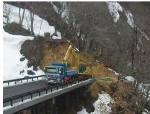
4月20日 工事着手
