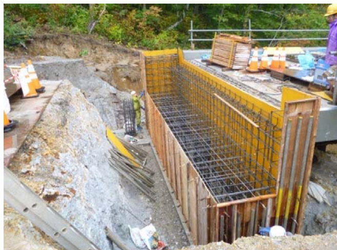
写真-3 A2土留擁壁 鉄筋・型枠設置状況
