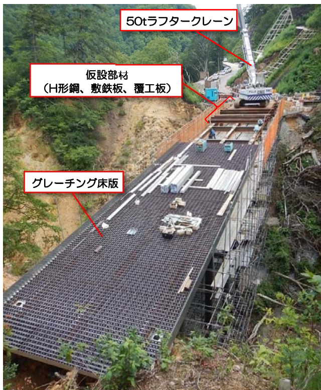
写真-1 グレーチング床版設置状況
