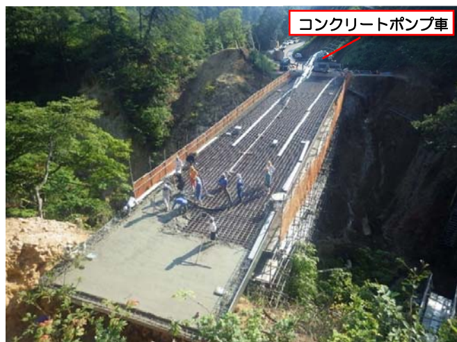
写真-2 床版コンクリート打設状況
