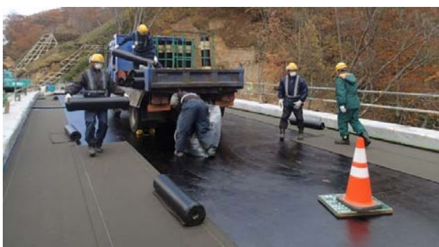
写真-4 橋面防水（シート系防水）施工状況
