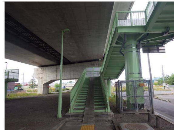
・完成（歩道橋部分補修工事）
