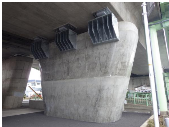
・完成（橋脚耐震補強工事）
