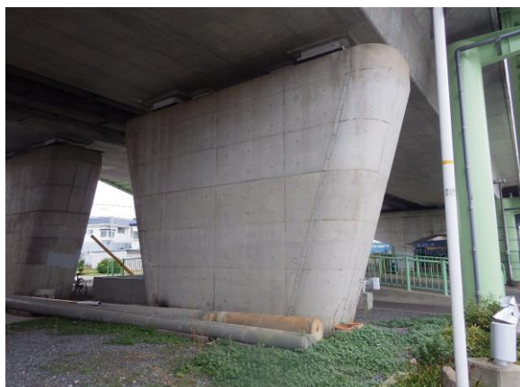
・着工前（橋脚耐震補強工事）
