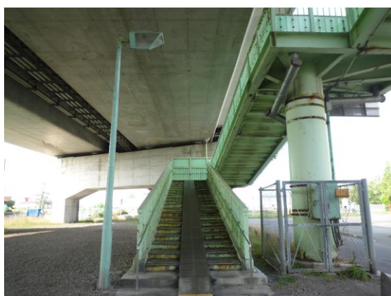
・着工前（歩道橋部分補修工事）
