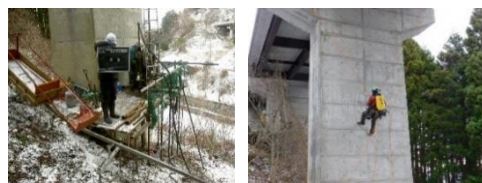
ロープアクセスによる 鉄筋探査
