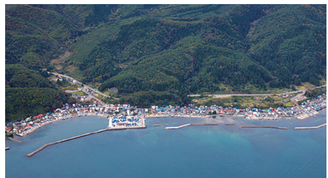
小湊港間木地区(地方創生推進交付金事業)
