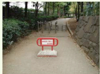
公園の出入口に設置した車止め
