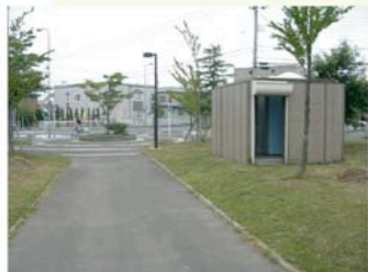
公園の出入口付近に設置した公衆便所
