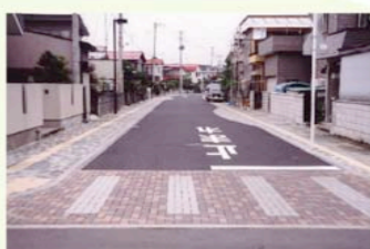
イメージハンプの設置による通過速度の抑制
