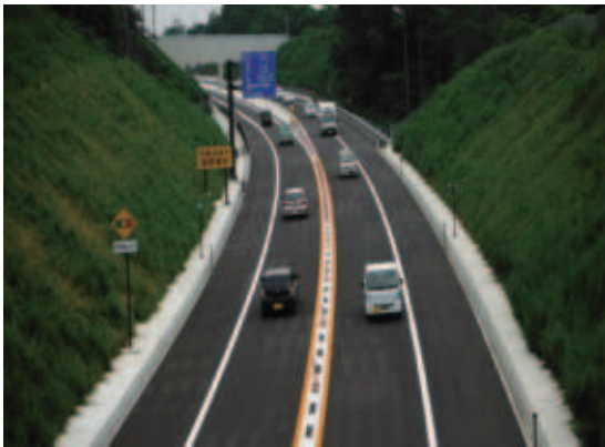
津軽自動車道（鱒ヶ沢道路）
