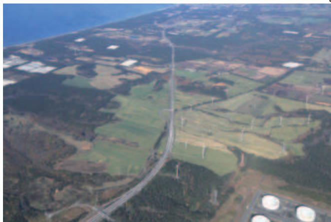
下北半島縦貫道路 吹越バイパス
