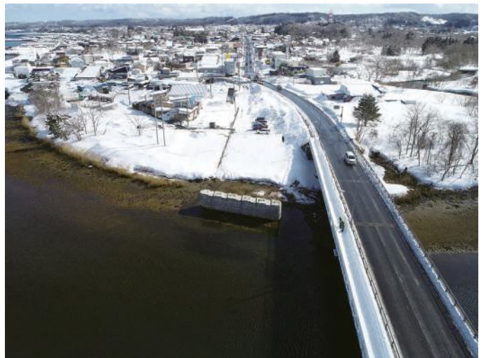
馬門野辺地線(野辺地橋)工事(野辺地町)
