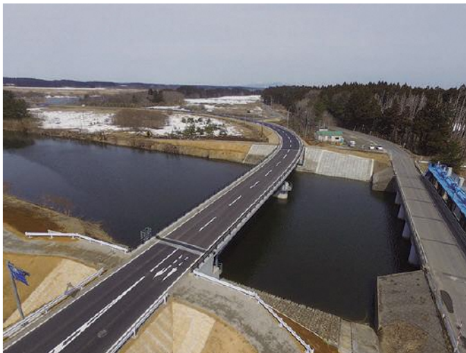
国道338号(高瀬川第二橋)工事(三沢市)
