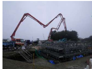
【施工状況（橋台躯体）】
