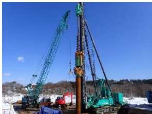
【施工状況（鋼管杭）】
