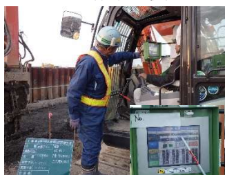
地盤改良施工管理状況
