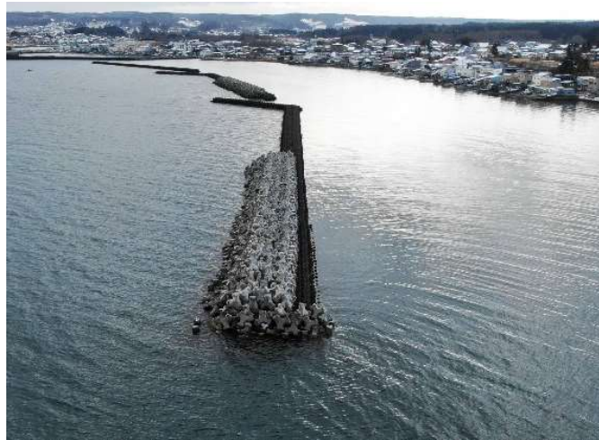
異形ブロック据付
