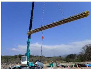
【施工状況（鋼管杭）】
