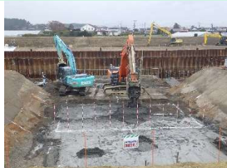
地盤改良施工状況
