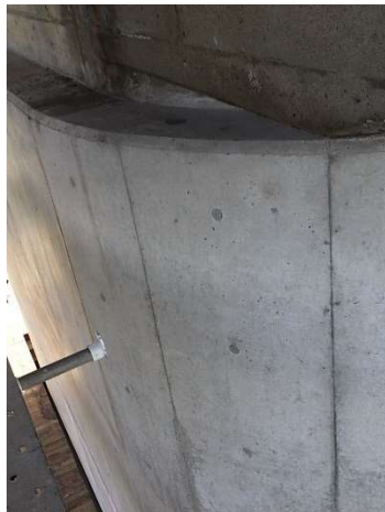
ひび割れ調査 (ひび割れの発生が見られない)
