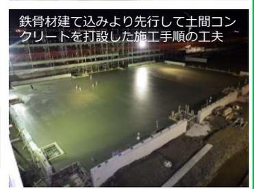
鉄骨材建て込みより先行して土間コンクリートを打設した施工手順の工夫
