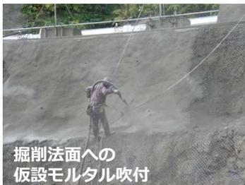
掘削法面への仮設モルタル吹付
