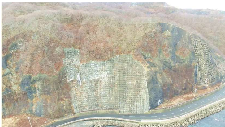
UAVを用いた点検
