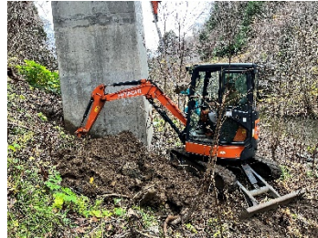
P3橋脚試掘状況
