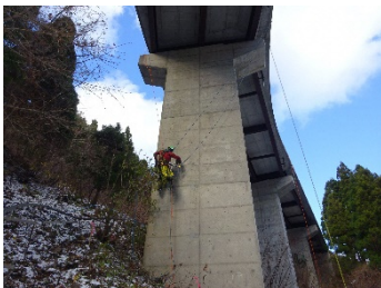
P4橋脚ロープアクセスによる鉄筋探査
