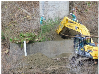
P1橋脚試掘状況
