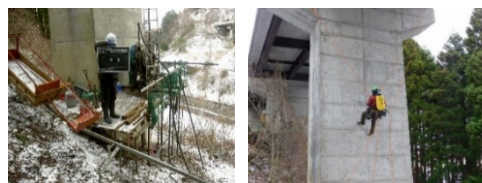
ロープアクセスによる 鉄筋探査
