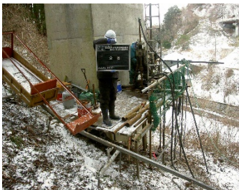
ボーリングによるP4橋脚試掘状況
