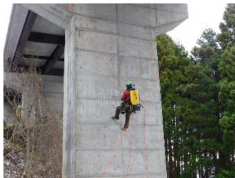
P5橋脚ロープアクセスによる鉄筋探査
