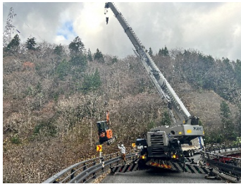
クレーンによる掘削機械の吊降し
