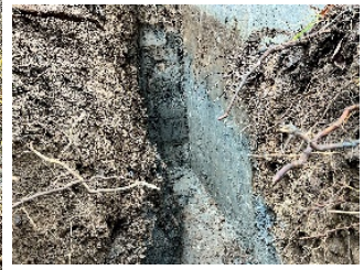
P3橋脚フーチング上面確認
