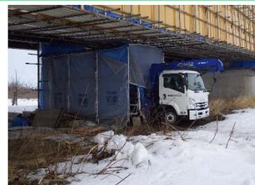
プラスチック機材一式を車載化
