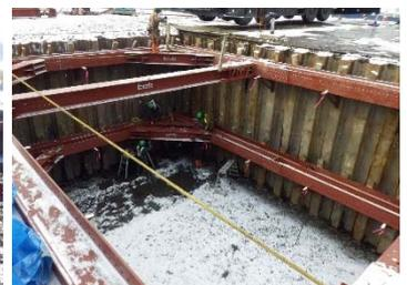
仮設土留工の腹起しを多重にして、安全性を高めて施工した
