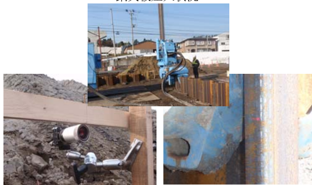
鋼矢板圧入状況
