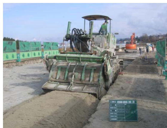
セメント飛散防止対策
