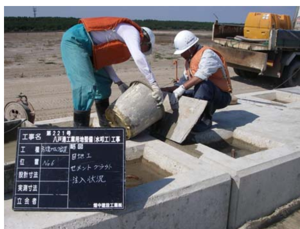
グラウト注入状況
