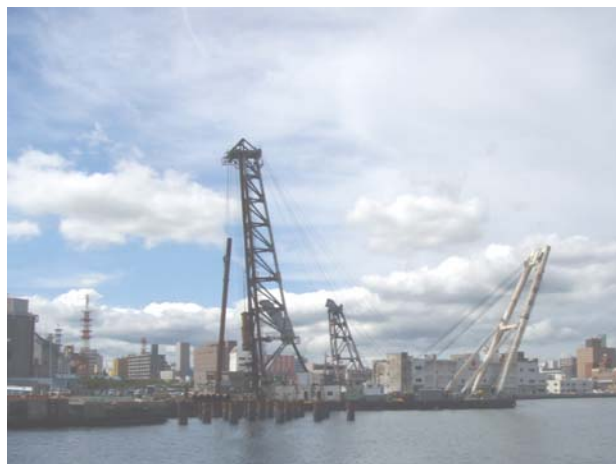
鋼管杭吊込み状況
