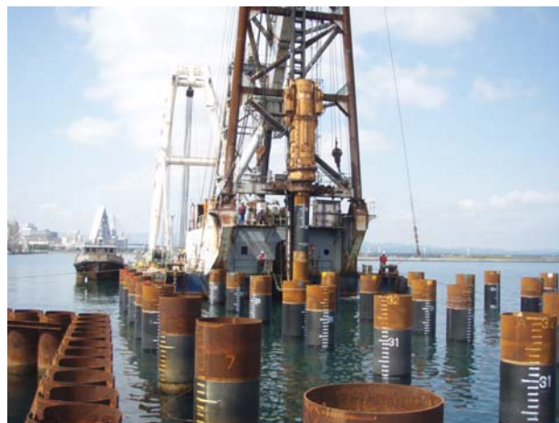
鋼管杭打込み状況
