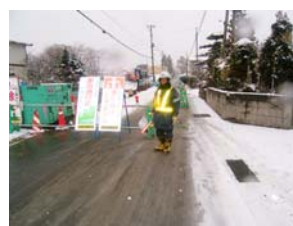
交通誘導員配置状況
