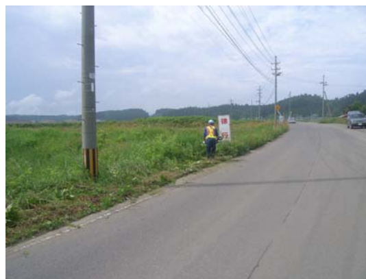
運搬路(村道)の環境整備
