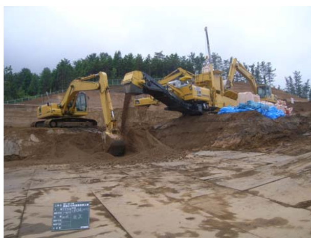
安定処理状況写真
