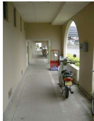
高い位置に設置された共用廊下に面する住戸の窓
