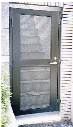
内外を見通せる構造の 共用階段の扉
