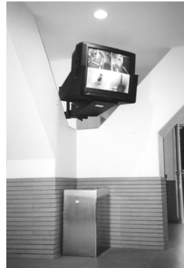
エレベーターホールにモニターを設置している例
