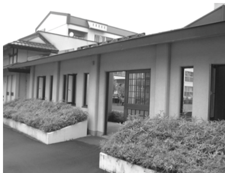
領域性の確保 敷地周囲に雁木空間を設置し、領域性を確保している
