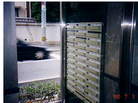
見通しが確保され、壁貫通型を採用した共用メールコーナー
