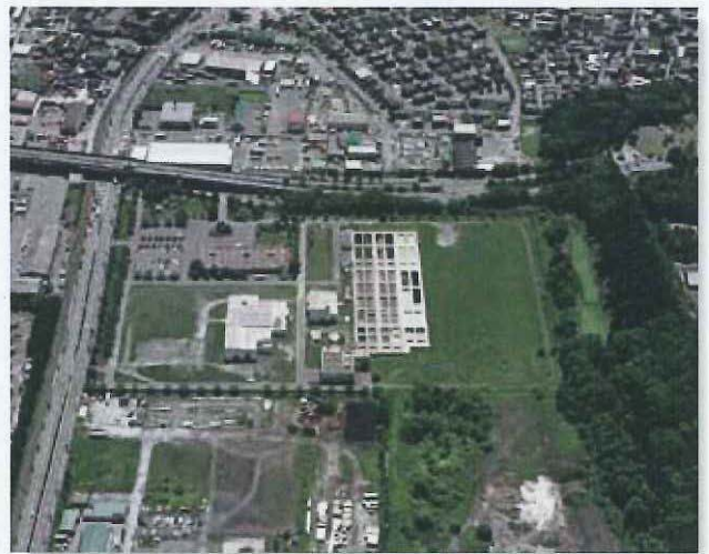
馬淵川浄化センター全景(八戸市)
