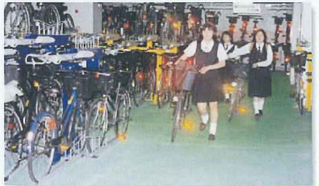
弘前駅前地下自転車駐車場(弘前市)
