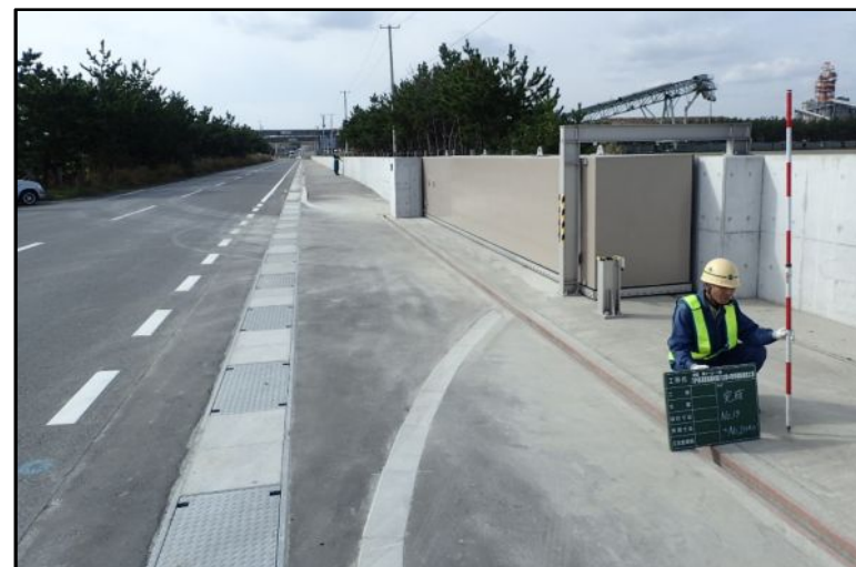
整備後:平成29年度
