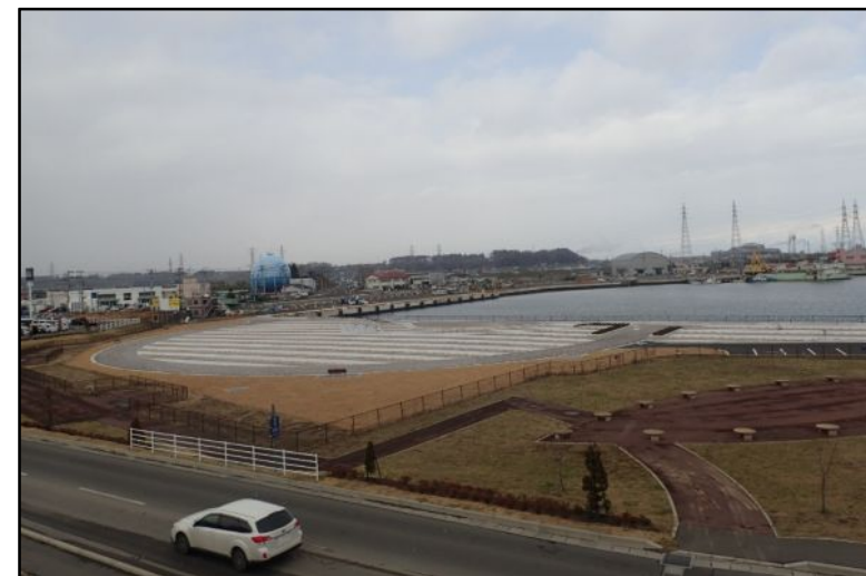
整備後:平成29年度
