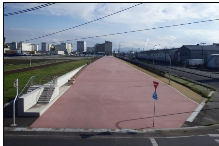
整備後:平成29年度
