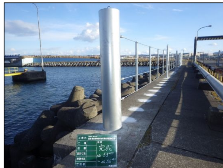
整備後:平成28年度
