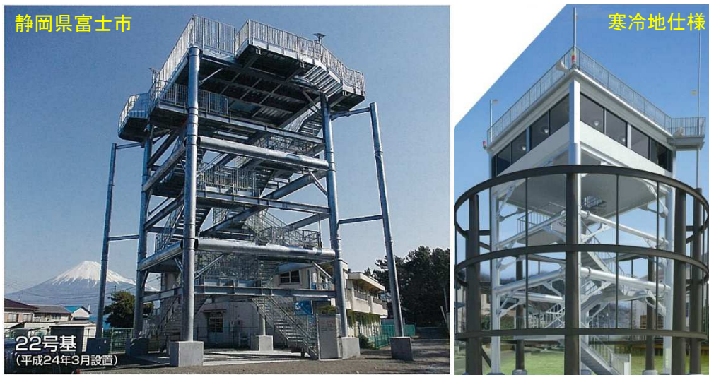
図-8.1 津波緊急避難施設の整備例
