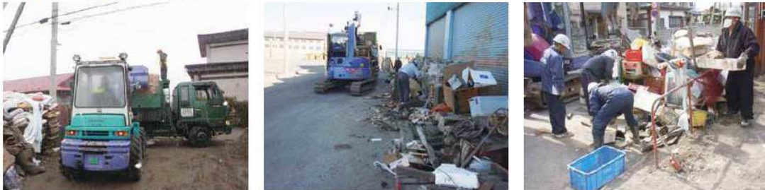
人力のみでは対応困難な場所が多かったため、重機・ダンプ等を用いて作業を行った。
