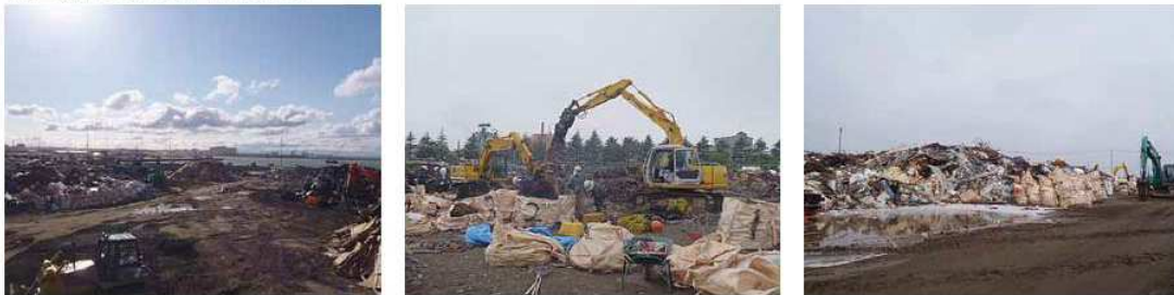
搬入受付、仮置場内誘導、分別作業を行っている。
