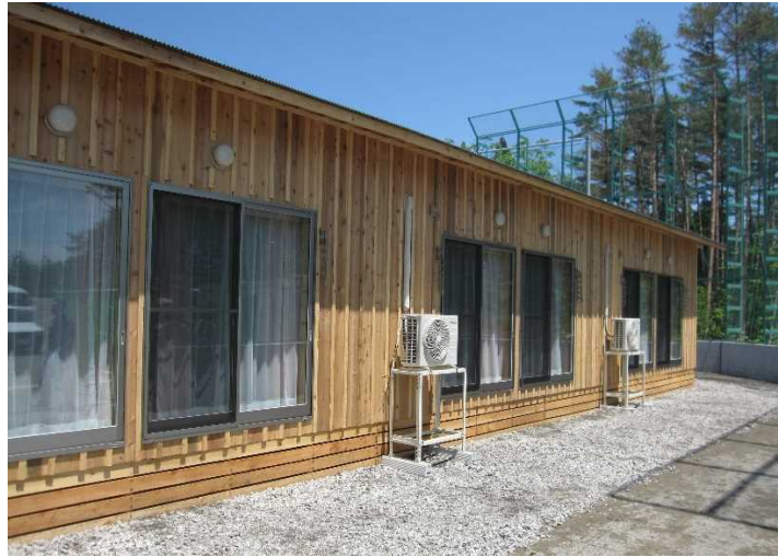
(地元建設業者による木造の住宅)
