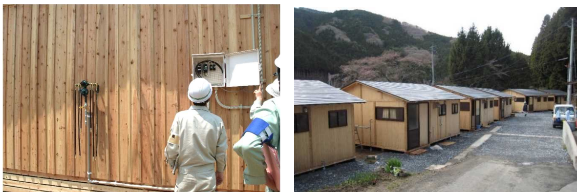
(完了検査状況)
