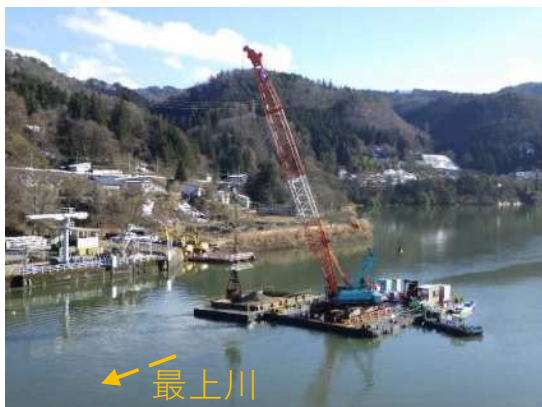
上郷ダムの浚渫 (山形)
