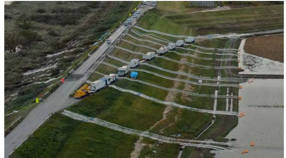
吉田川における排水作業状況
