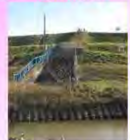
内浦緊急排水樋門（呑口部）
