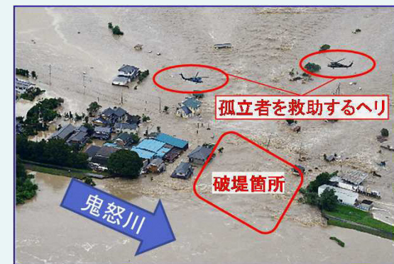
鬼怒川の浸水被害の様子 (平成27年9月 関東・東北豪雨)
