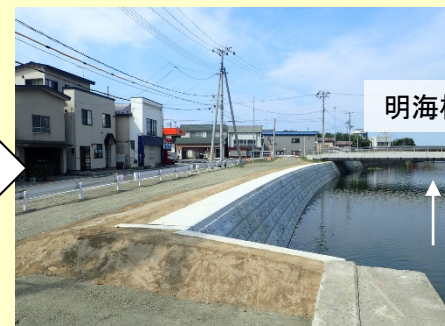
改修後 (平成29年9月完成工区)
