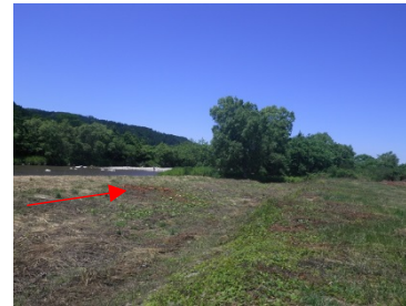
(雑木伐採状況)
