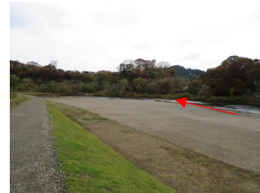
(河床掘削状況)
