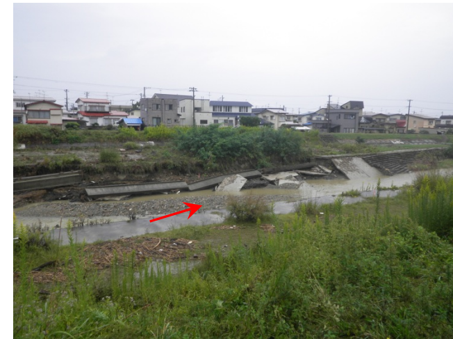
大和沢川(弘前市)
