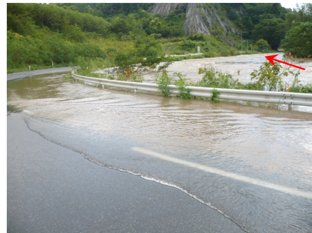
新井田川(八戸市) 島守是川線冠水状況
