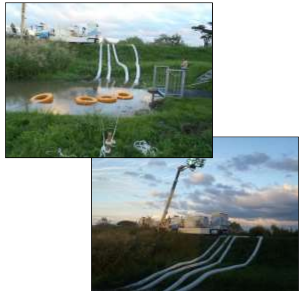
赤川破堤時の排水活動（東北町 H28 台風第9号）
