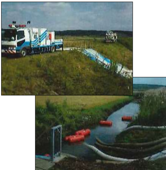
二ツ森橋下流での排水活動（東北町 H18 出水）
