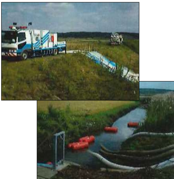
二ツ森橋下流での排水活動（東北町 H18 出水）
