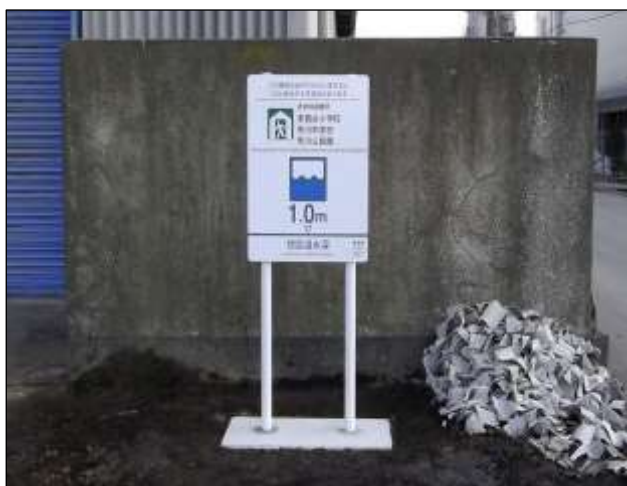
看板設置：五戸川（八戸市）
