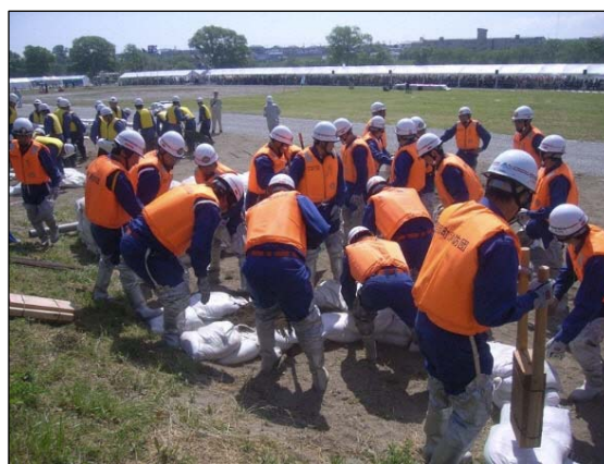
水防訓練の状況：馬淵川（八戸市）
