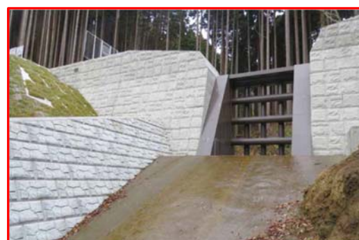
透過型砂防堰堤
