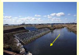
【明神川】沼端1号橋付近(R1施工箇所)
