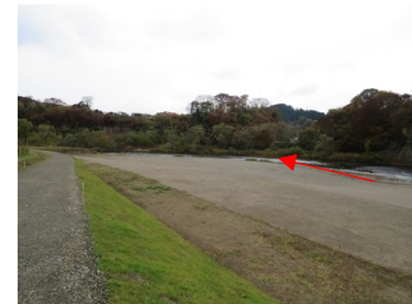
(河床掘削状況)
