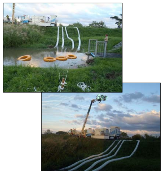
赤川破堤時の排水活動（東北町 H28 台風第9号）
