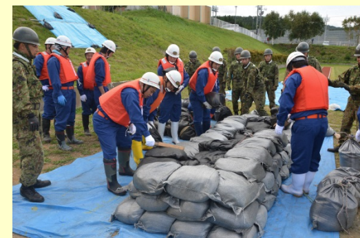
上写真：シート張り工法 (参考：H28防災訓練)
