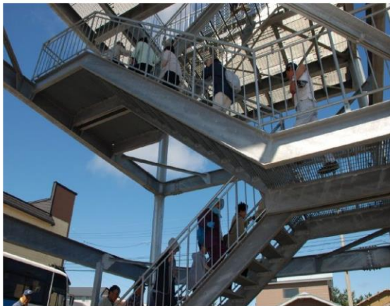
津波避難タワーへの避難訓練の実施（28年度） ※写真は磯松地区津波避難タワーへの避難訓練の様子 （7月24日「総合防災訓練」にて）
