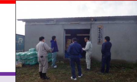
水防倉庫合同巡視状況(むつ市 文京町)
