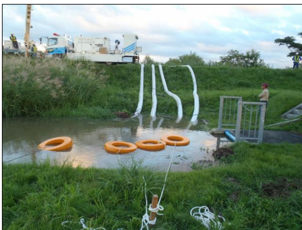
赤川破堤時の排水活動（東北町 H28 台風第 9 号）
