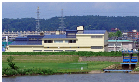
●下長雨水ポンプ場（平成22年度供用開始）
