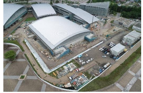
建設中の新水泳場
