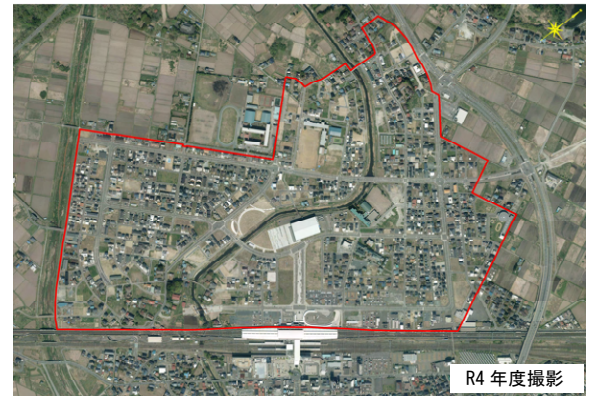
八戸市 八戸駅西地区土地区画整理事業
