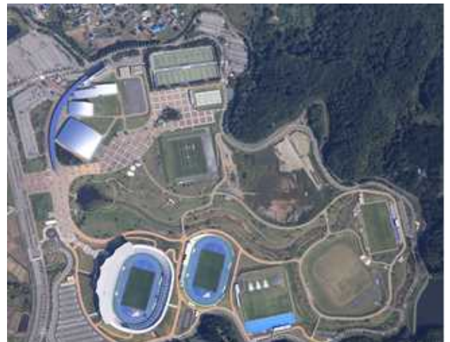
●新青森県総合運動公園（全景：青森市）
