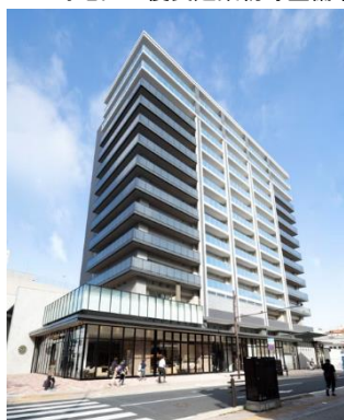
(八戸市) 八日町地区 優良建築物等整備事業
