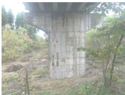
▲ 青森浪岡線 王余魚沢橋耐震補強の例
