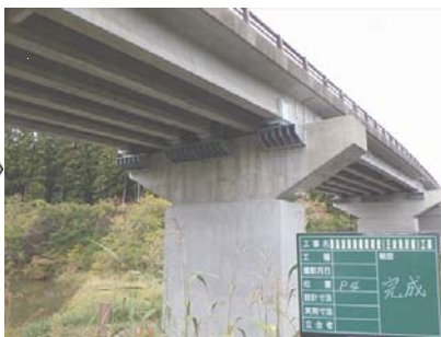
▲ 青森浪岡線 王余魚沢橋耐震補強の例
