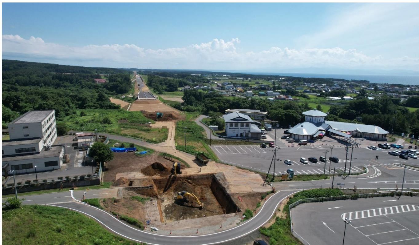
建設中の下北半島縦貫道路（横浜町）
