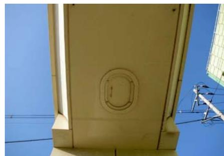
国道454号 合同庁舎前歩道橋（箱桁点検孔の施錠点検）
