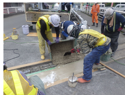
伸縮装置補修
