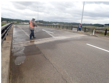
伸縮装置清掃
