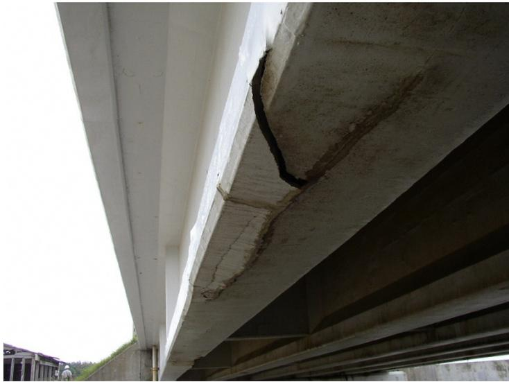
海からの飛来塩分でPCケーブルが腐食し、主桁下面に大きなひび割れが発生しています。
