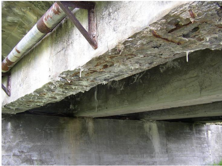
冬期間の凍結融解作用で、主桁下面のかぶりコンクリートが剥がれ、一部鉄筋が露出しています。
