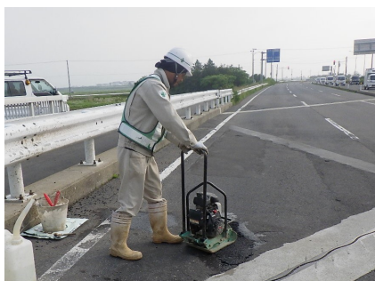
欠損部補修
