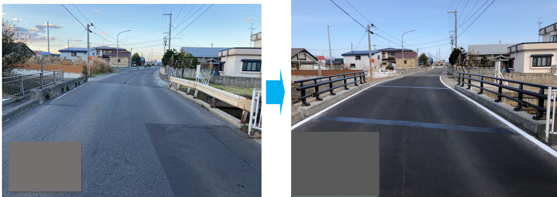
国道280号 瀬戸子橋 舗装打替、伸縮装置取替、高欄取替
