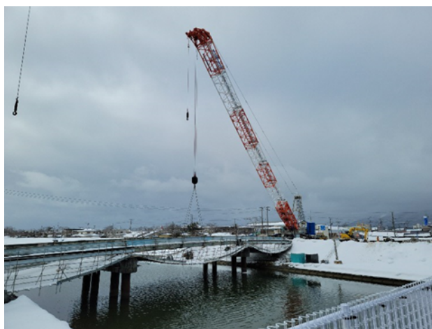
むつ尻屋崎線 赤坂橋 旧橋撤去施工状況
