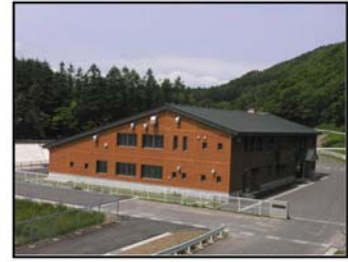
しんしゅつすいしよりにしせつ たてももの 浸出水処理施設の建物
