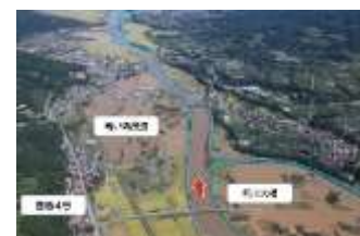
平成25年台風18号による河川の氾濫の状況
