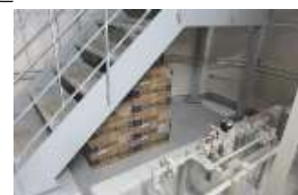
吸水性土のうの備蓄の状況
