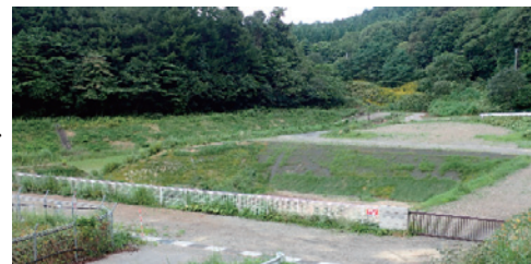
浸出水処理施設跡地 (R5. 8撮影)
