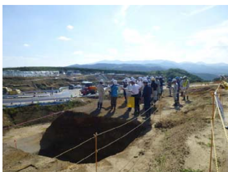
地山確認状況2 (選別施設南側)
