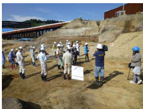
地山確認状況3 (旧洗車場西側)
